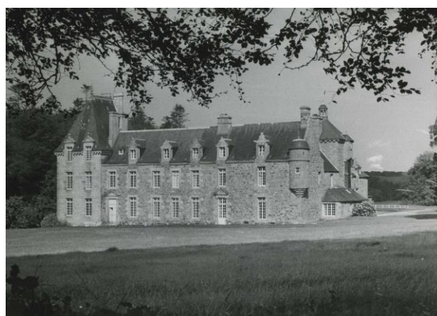
Château de Kerduel, ensemble sud-est (Source : Médiathèque de l'Architecture et du Patrimoine)
