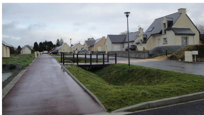
Exemple de noue, Lotissement à Bégard Arch/Urba : Jorand & Mongkhoun
